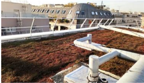
Toiture végétalisée (Source : AESN)
