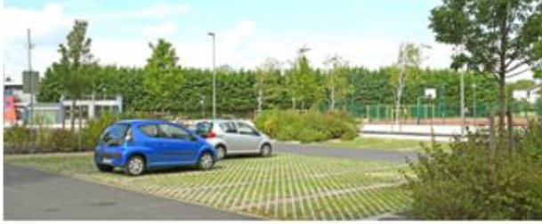
Parking avec dalles engazonnées, La Courneuve (Source : AESN)
