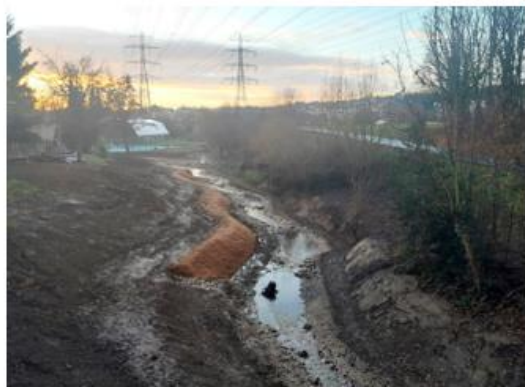
Photo de chantier, décembre 2022 – Secteur Tennis d'Igny
