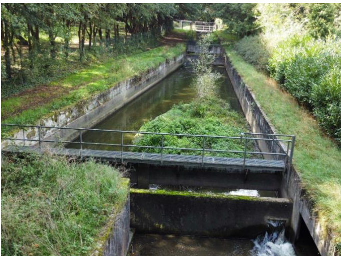
Photo du secteur Bas-Prés avant le début des travaux
