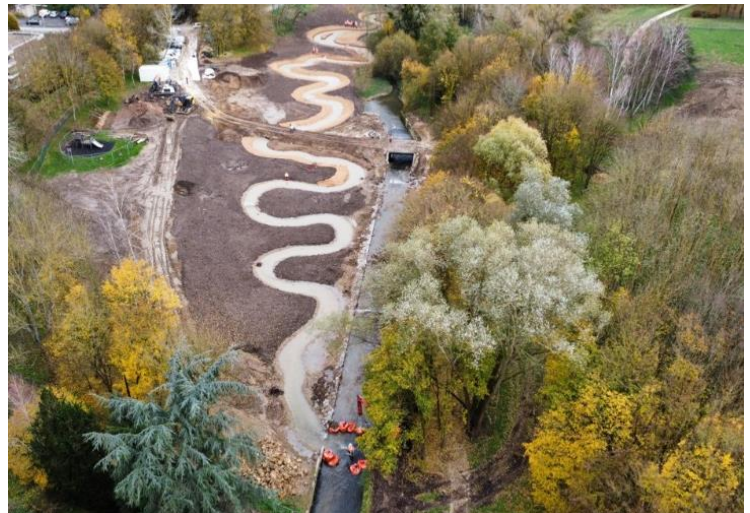
Photo de chantier, décembre 2023 – Secteur Bas-Prés
