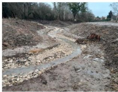
Photo de chantier, décembre 2022 - Secteur Bassin des Sablons, Vauhallan
